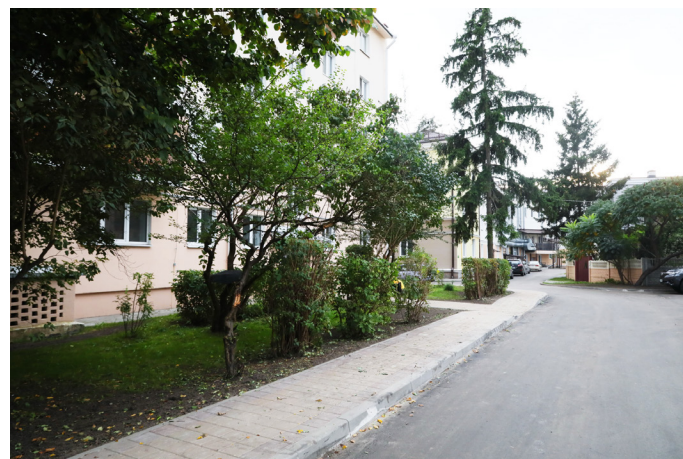
Дворовая территория дома на Гоголя, 68 ПОСЛЕ РЕМОНТА
