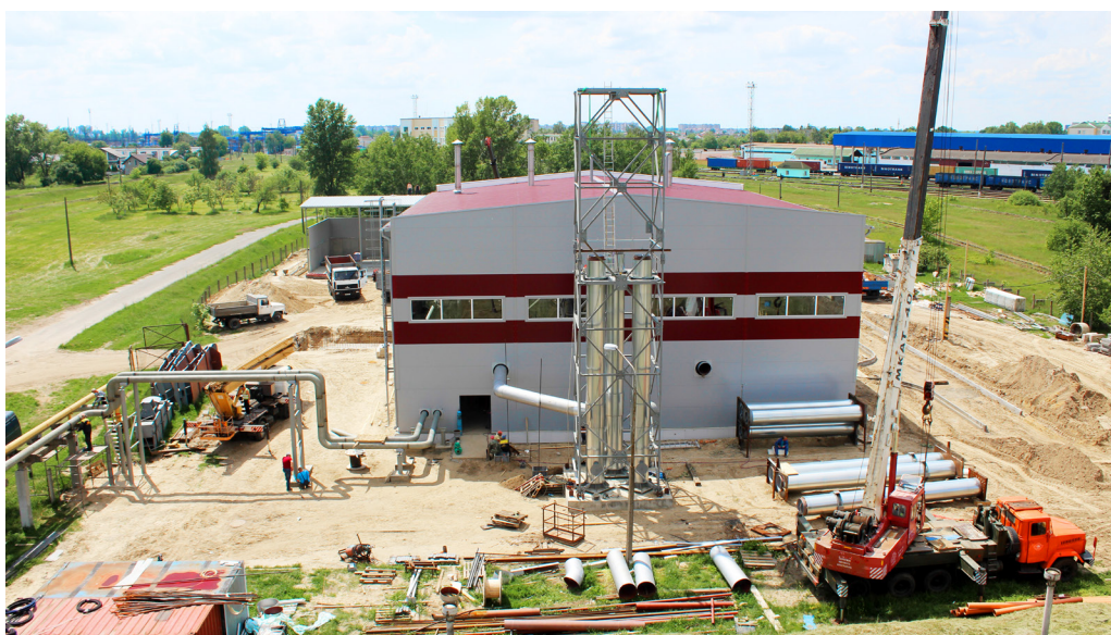
Строящийся микрорайон на Лейтенанта Рябцева.
