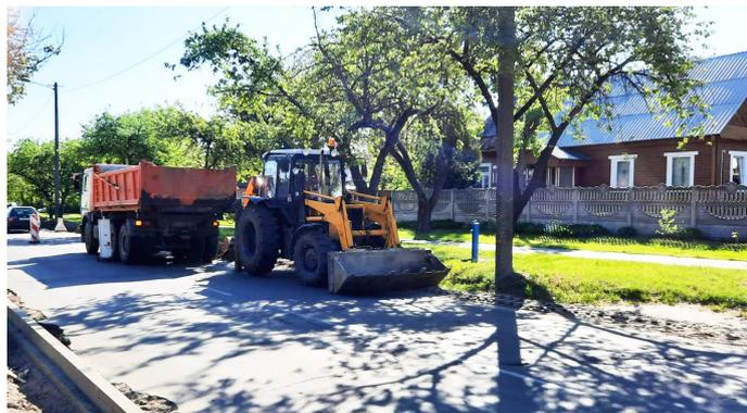
Здесь проведут комплексный ремонт на участке от ул. Спортивной до ул. Осипенко. Предполагается замена дорожного борта, ремонт ливневой канализации, замена верхнего слоя асфальтобетонного покрытия. При благоприятных погодных условиях работы будут завершены к 20 июня.
