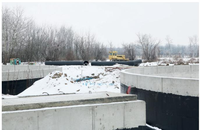
Завершены работы и на двух вторичных отстойниках – камерах возвратного ила. Как только гидравлические испытания завершатся, начнется дальнейшее установление оборудования.
