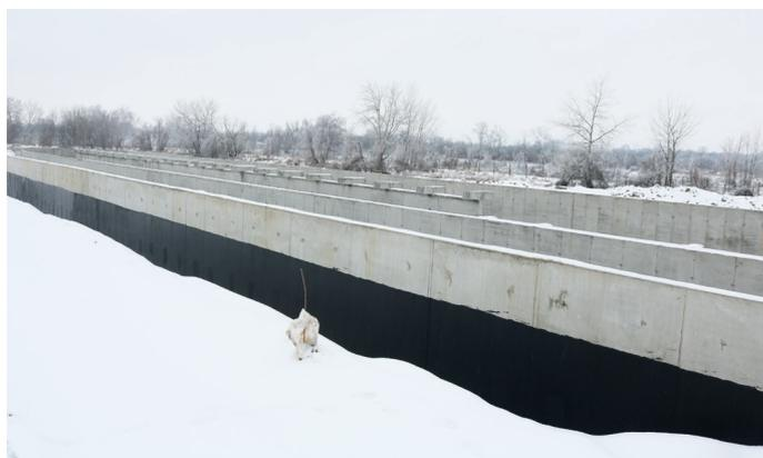
А это – аэротенки с подающим лотком, предназначенные для биологической очистки. Они готовы к гидравлическим испытаниям, после которых будет установлено технологическое оборудование.
