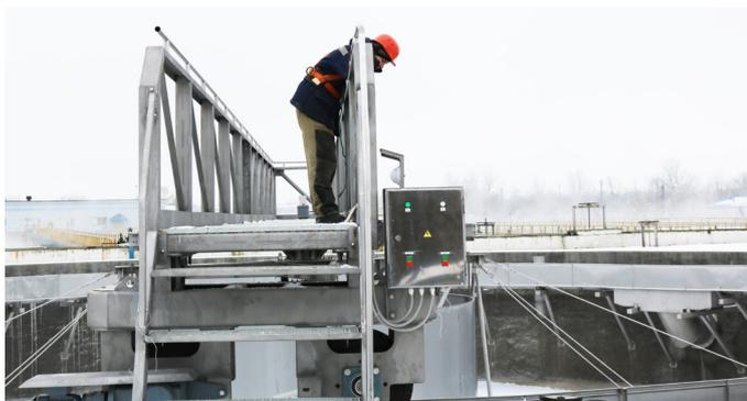
Ближайший объект на пути следования – два первичных отстойника. Здесь производились работы по защите бетона, выровнен оголовок, также заменено оборудование. Для полного завершения работы по данному объекту надо будет реконструировать насосную станцию, предназначенную для удаления из отстойников сырого осадка.
